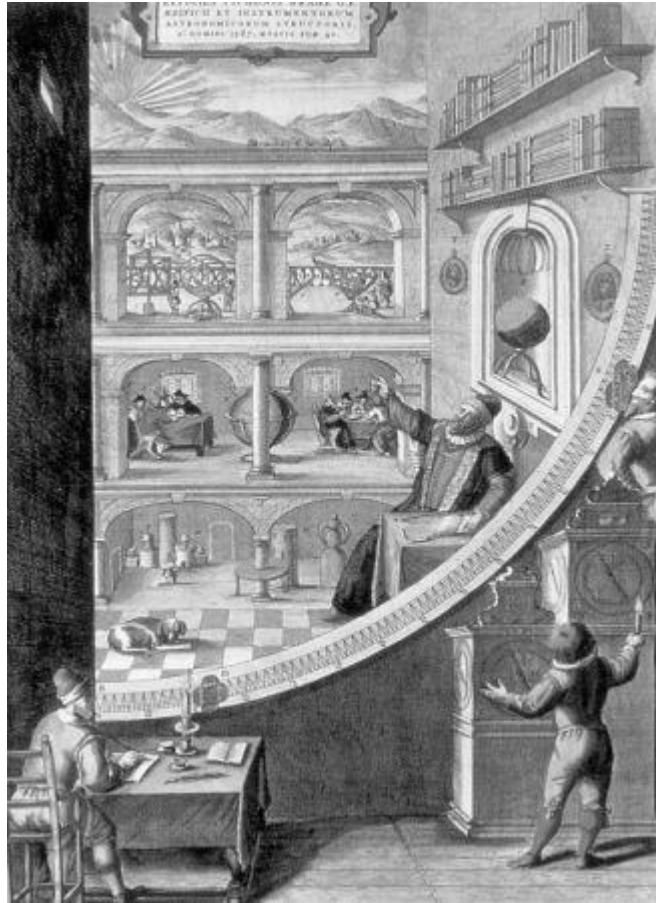
El gran mural astronómico, pintado en el observatorio de Uraniburgo, para medir las altitudes a las que los cuerpos celestes cruzaban el meridiano. En él aparece Tycho Brahe. Lámina de Astronomiae instauratæ mechanica (1602).
